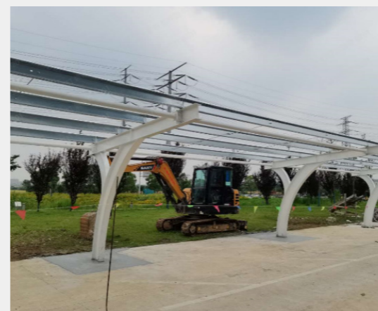
蜂巢能源常州园区光伏车棚项目施工现场
